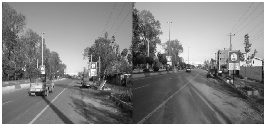
شکل ۲: ورودی شهر ایزد شهر پس از نصب تابلوها
